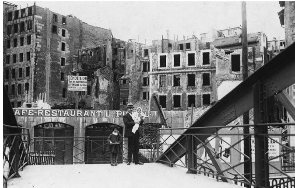
Michel Bruno (?), Démolition du quartier du Seujet en 1931.
